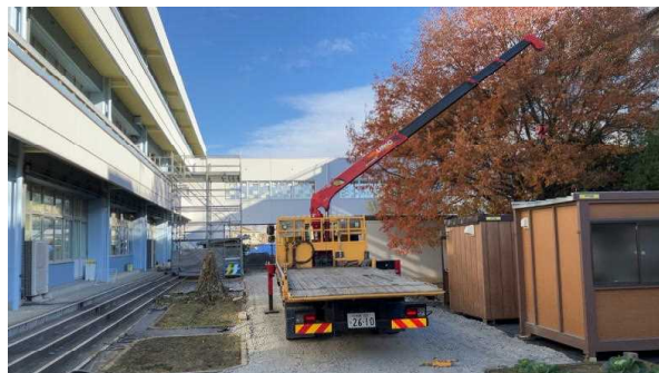
新給食室建設もあり東も西も中庭は工事車両ばかりです
